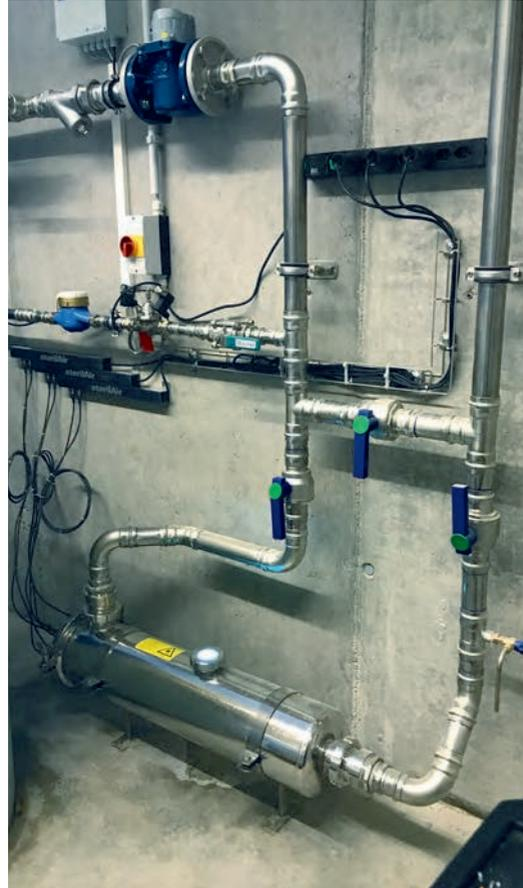
*sterilAir® AQD-ST utilizzato per disinfettare
